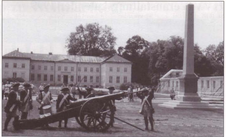
Böllerschüsse zum Jubiläum am 26. Juni 1998 vor dem rekonstruierten Obelisk und dem Schloß Neuhardenberg. Die Umbauarbeiten zum Schulungszentrum des Deutschen Sparkassen- und Giroverbandes haben bereits begonnen.
