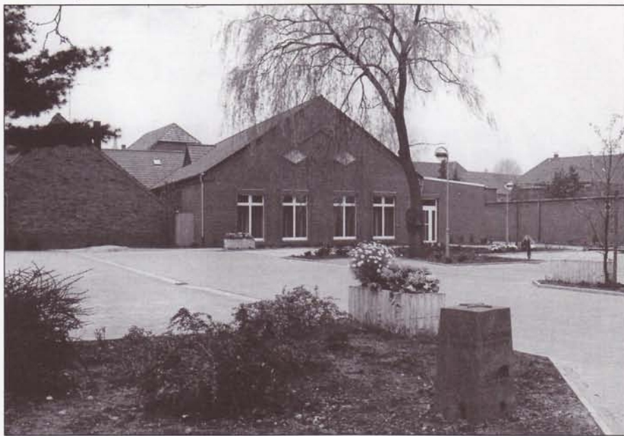
Das Bürgerhaus Friedenshalle in Hamminkeln nach der Eröffnung am 30. April 1988.
