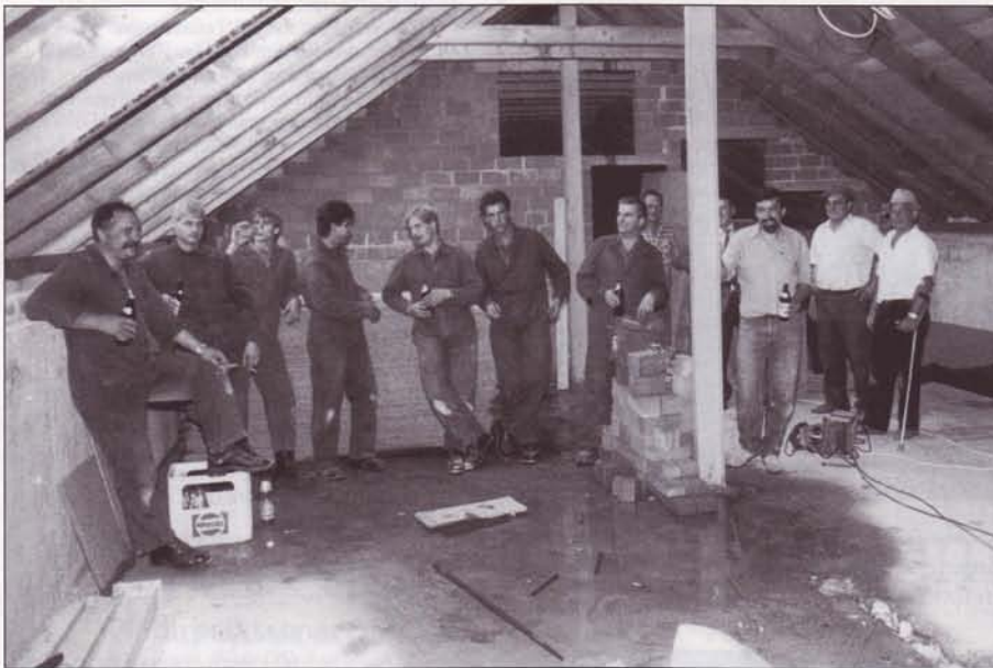
Mithilfe der Patensoldaten beim Bau des Bürgerhauses am 14. April 1987.
