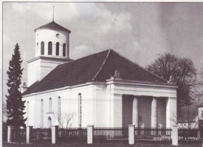
Dorfkirche Neuhausen; Mittelalterlicher Feldsteinbau, 1801 ausgebrannt, 1815/17 von K. F. Schinkel ausgebaut und klassizistisch überformt.
