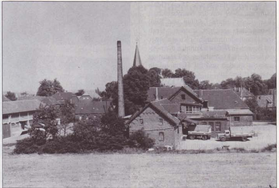
Blick auf die Molkerei Hamminkeln im September 1958...
