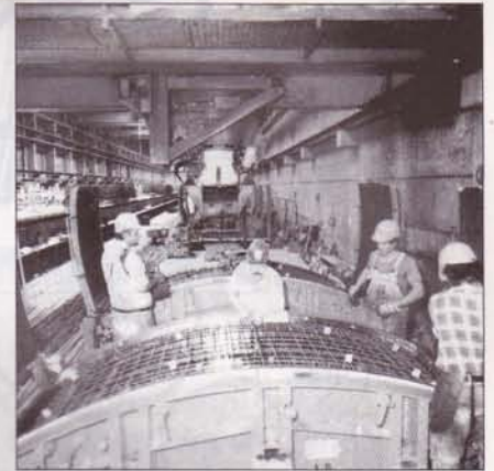
Tübbingfertigung Halle II.
